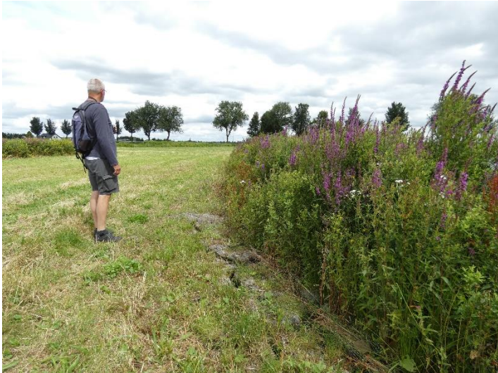
oeverstrook binnenzijde (met scheuren in de kleigrond)
